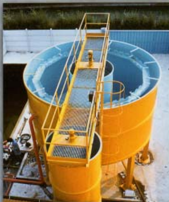
IMPIANTO CHIMICO FISICO PER INDUSTRIA GALVANICA CHEMICAL-PHYSICAL PLANT FOR GALVANIC FACTORY WASTES
