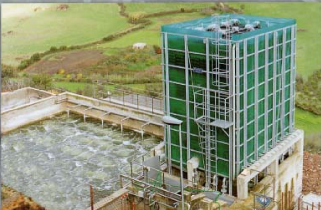
IMPIANTO BIOLOGICO PER ACQUE AD ALTO CARICO ORGANICO BIOLOGICAL PLANT FOR HIGH ORGANIC LOAD WASTES
