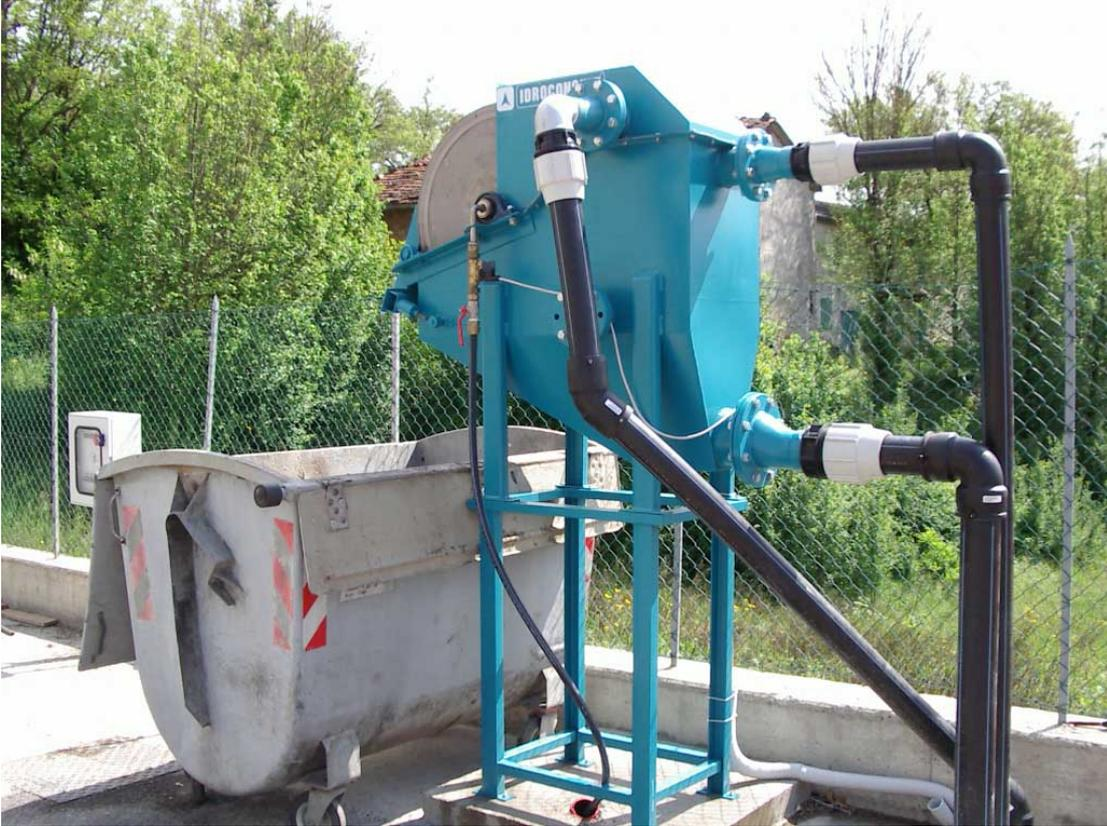
Filtro a tamburo fino a 15 m<sup>3</sup>/h installato in area lavaggio compattatori in Silla (BO)
