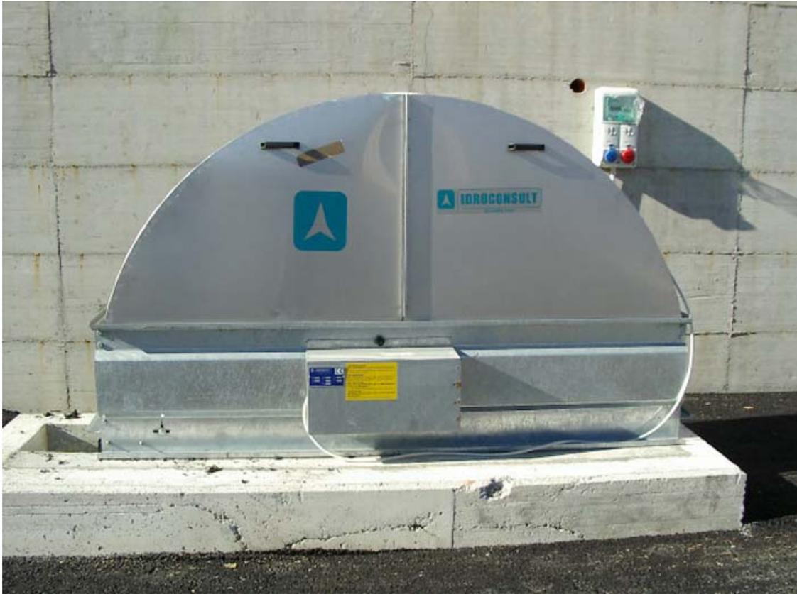
Filtro a spazzole rotative installato in Area lavaggio compattatori in Osson
